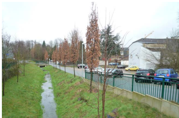
Abbildung 25: Seitenarm des Loemühlenbachs im Stadtteilzentrum Hüls
